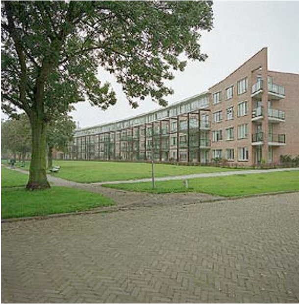
Parkzicht Prinses Margrietlaan Atriumgebouw
